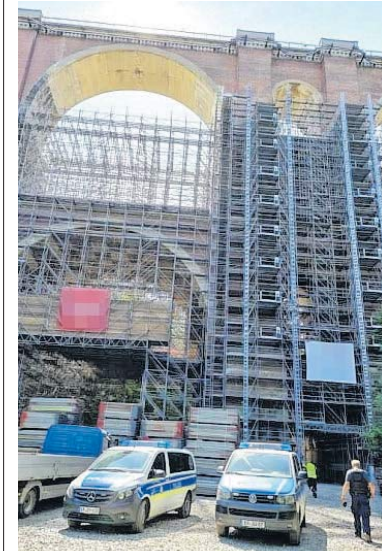
Ein Großaufgebot an Rettungskräften war am Montag an der Elstertalbrücke im Einsatz. Die Brücke wird derzeit saniert. FOTO: ELLEN LIEBNER
